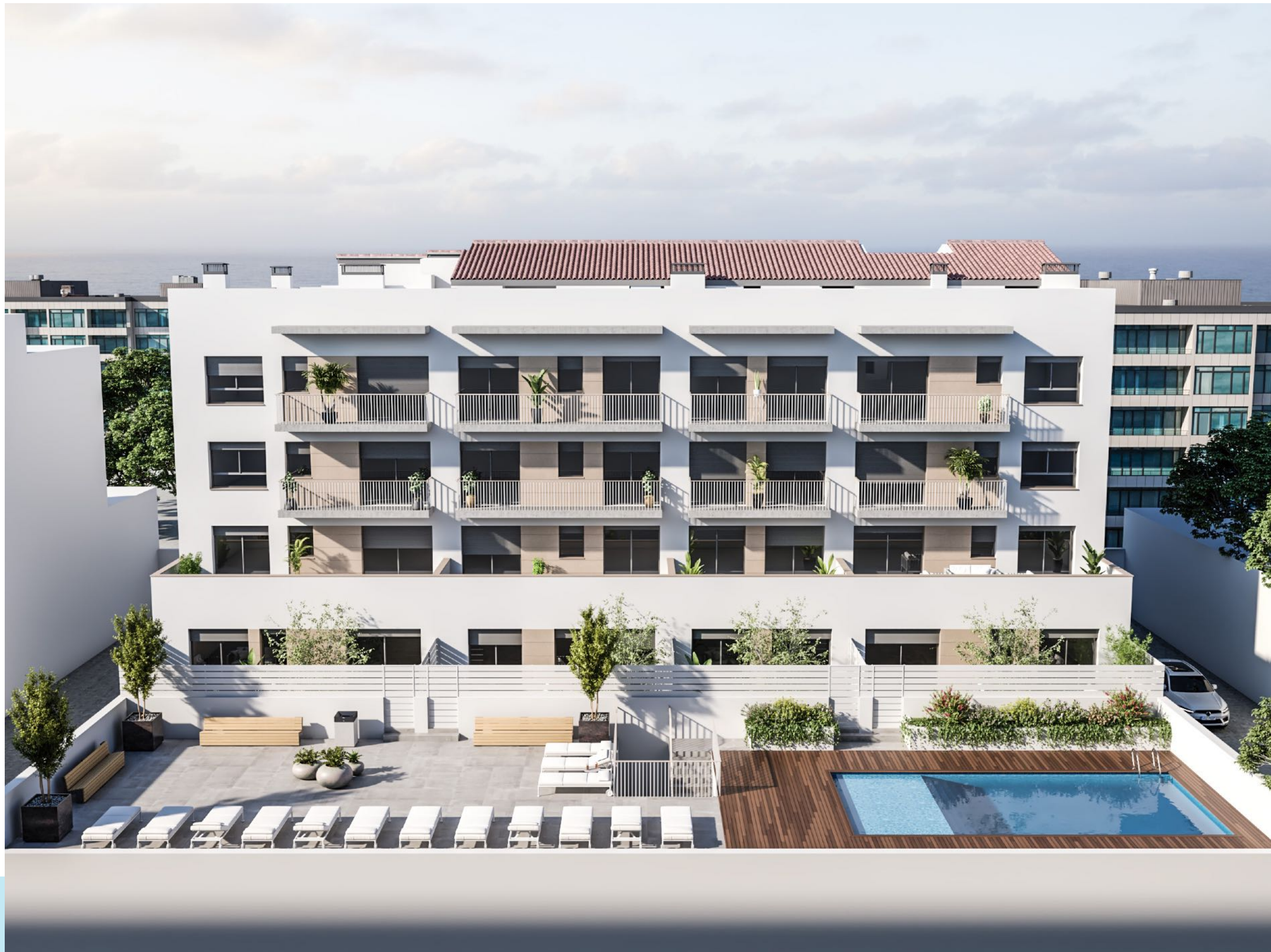
VISTA GENERAL EXTERIOR FAÇANA POSTERIOR AMB ZONA COMUNITÀRIA AMB TERRASSA I PISCINA
