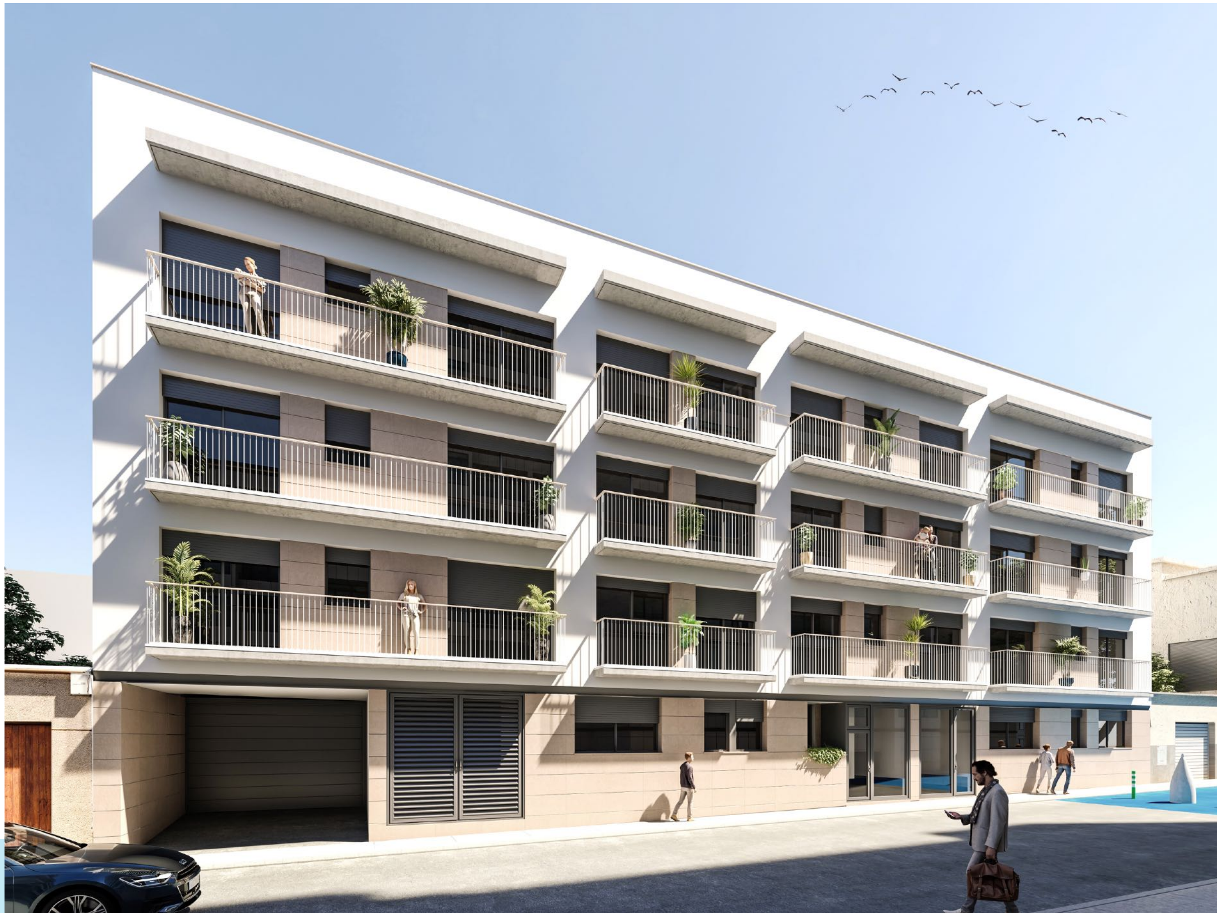
VISTA EXTERIOR FAÇANA AL CARRER PERE RIUDOR
